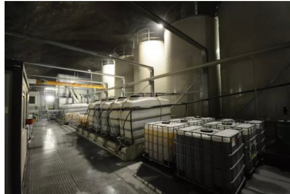
Betonmischung in Kaverne
